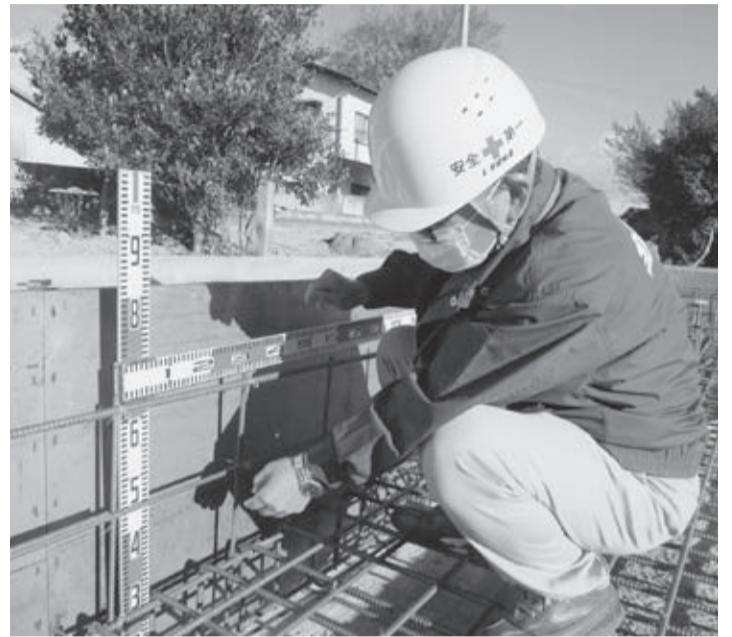
基礎配筋完了検査を実施する団体検査員の山崎久夫さん(郡山建設組合)
