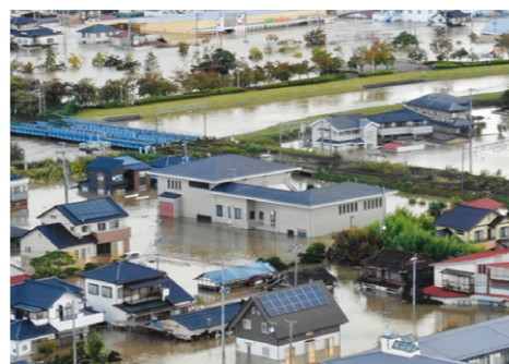
台風19号による被災状況(本宮市)
