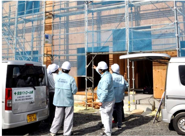
パトロール現場で足場の安全確認をするようす
